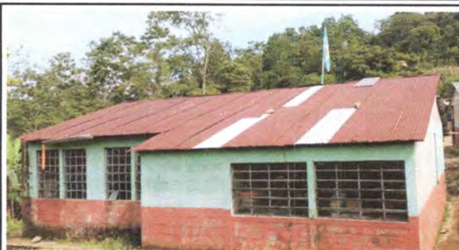
Foto 1: Sustitución de láminas por lámina troquelada aluzinc calibre 26 modulo 1
