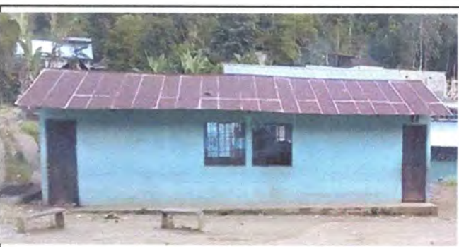
Foto 5: Sustitución de laminas por laminas troquelada aluzinc calibre 26
