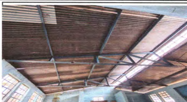
Foto 2: Mantenimiento de estructura de soporte de metal aplicación de pintura modulo 1
